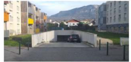
Trémie de parking souterrain en coeur d'ilot (Aix-les-B. Lafin, 2020)
