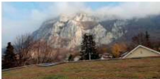
Exemple de toiture végétalisée à Colonges (74)
