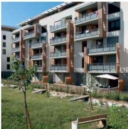
Exemple de noue plantée dans l'éco-quartier de Vallin-Fier & Anney (74)
