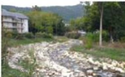
Les berges du Sierraz : un territoire oublié et absent des grands aménagements contemporains ; un paysage remarquable à redécouvrir et investir dans les projets d'aménagement
