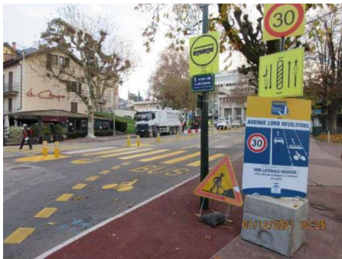
Aménagements temporaires sur l'Avenue Lord Revelstoke
