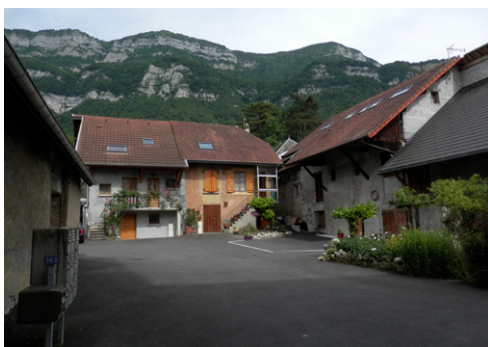
MERY - imperméabilisation de la cour centrale
