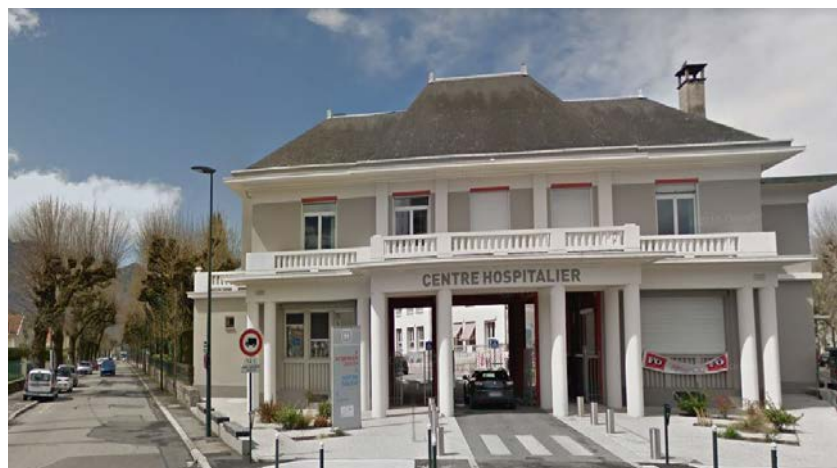
Hôpital Grand Port d'Aix-les-Bains
