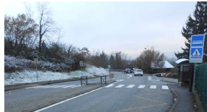
Sécurisation des traversées sur la D913 à Mouxy
