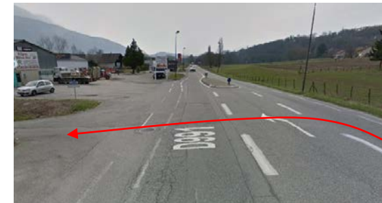
Absence de traversée sur la D991 pour relier l'itinéraire cyclable vers Savoie Hexapôle – Source : Google Maps
