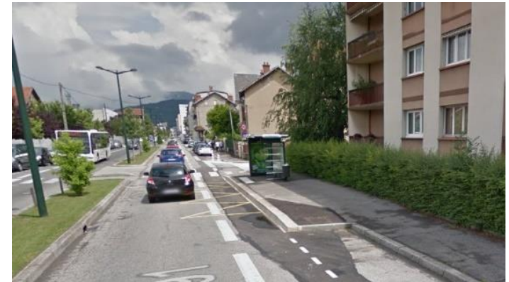
Les aménagements du Boulevard de Russie dans le centre-ville d’Aix-les-Bains, intègrent un partage équilibré de la voirie avec files de circulation et de stationnement, arrêts en ligne, espaces piétons et bandes cyclables
