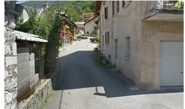
Voirie du centre ancien de Serrières en Chautagne, l’absence de trottoir est préjudiciable mais peut être palliée par la mise en place d’une zone pacifiée
